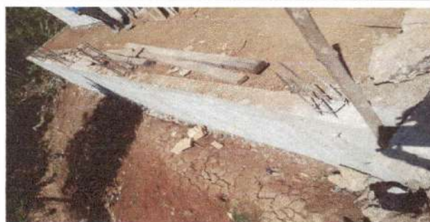
Foto 6: Reparación de muro del centro educativo.
