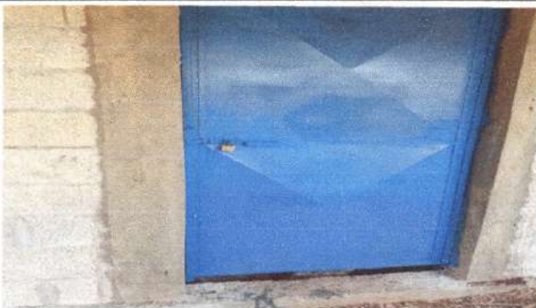
Foto 3: LA puerta esta instalada.
