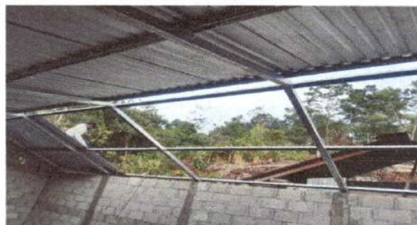
Foto 4: Se cambió la estructura de techo de la cocina.
